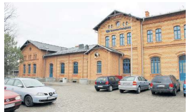
Od 1 czerwca gmina Strzelin przejmie ochronę dworca PKP i zacznie korzystać z wyremontowanych pomieszczeń
