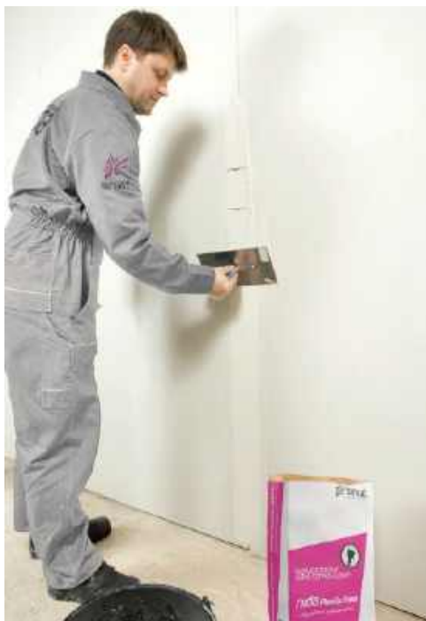
🔗 Łączenia płyt g-k wykańcza się specjalną taśmą i masą szpachlową. W ten sposób łączenia są trwałe i niewidoczne – powstaje jednolita płaszczyzna. SINIAT
