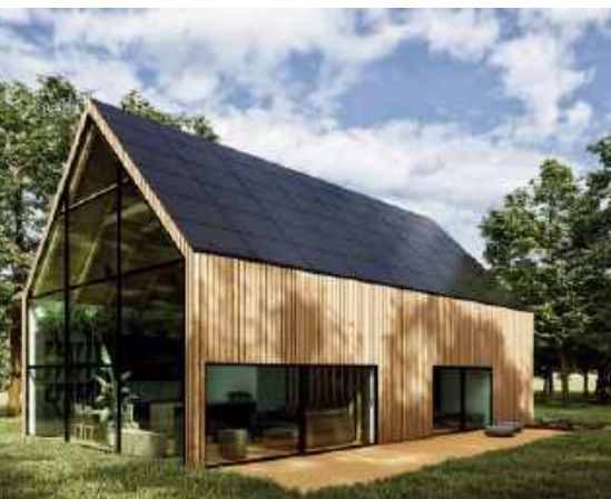
Dach solarny to bardzo nowoczesna instalacja. Jest połączeniem elementów stanowiących pokrycie dachu z systemem paneli fotowoltaicznych. SUNROOF
