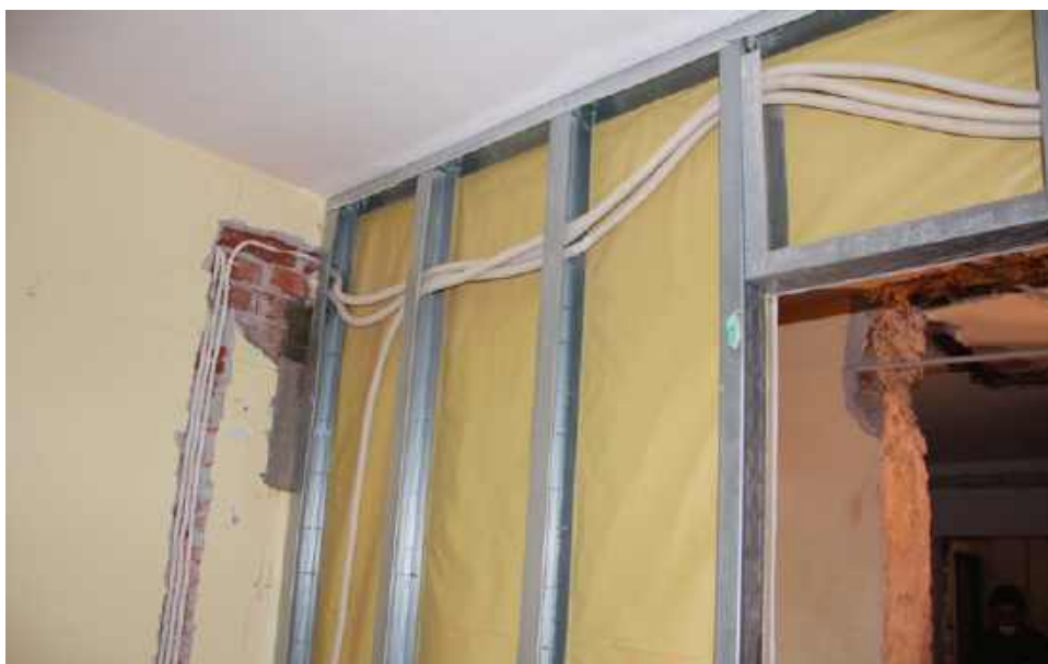
🔧 Do ukrycia przewodów tworzących nowe obwody elektryczne można z powodzeniem wykorzystać np. wnętrza ścianek szkieletowych. J. WERNER
