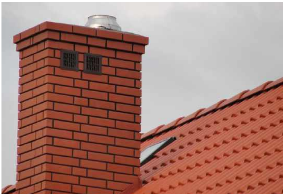
❷ Kontroli podlegają nie tylko przewody spalinowe, ale również wentylacyjne. JAWAR
