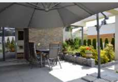
➡ W 2018 r. taras (28 m 2 ) wykończono na sucho płytami z betonu.
