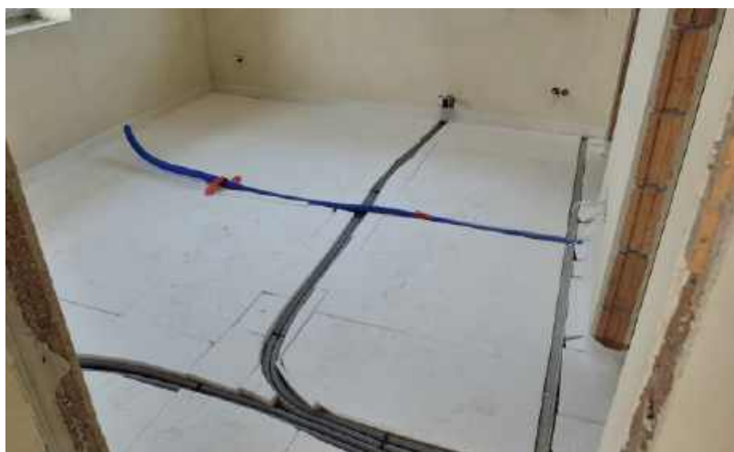
Podłogi ocieplamy styropianem typu dach/podłoga. A. PAPLIŃSKI
