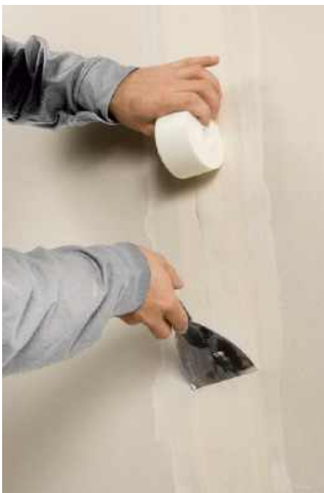
🔗 Łączenia płyt g-k wykańcza się specjalną taśmą i masą szpachlową. W ten sposób łączenia są trwałe i niewidoczne – powstaje jednolita płaszczyzna. SINIAT
