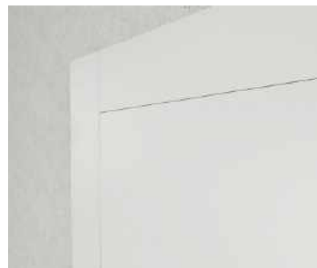
🔧 Ościeżnica regulowana z płyty MDF do drzwi bezprzylgowych. Ponieważ zachodzi ona na mur, listwy maskujące nie są potrzebne. VOSTER
