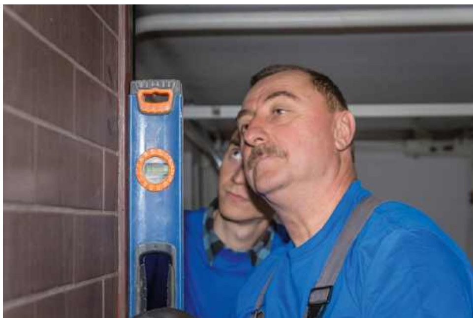
🔧 Po zdemontowaniu starej bramy trzeba dokładnie wyrównać otwór wjazdowy. Jeżeli na powierzchni pozostaną ubytki i krzywizny, wrota będą nieszczelne i nie będą prawidłowo działały. NOVOFERM
