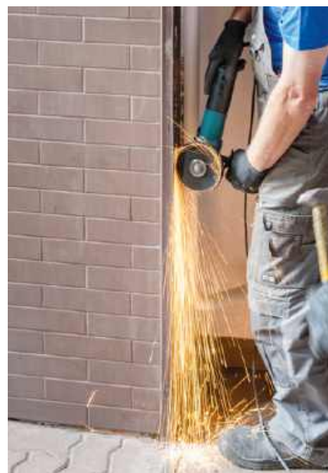
🔧 Wycinanie ościeżnicy starej bramy za pomocą szlifierki. NOVOFERM
