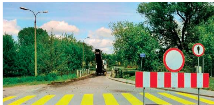
Most na Łydynie przy ulicy Augustiańskiej
