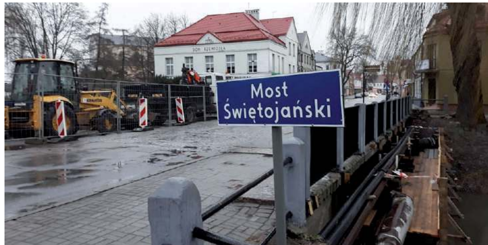
Część mostu wyłączona z ruchu
