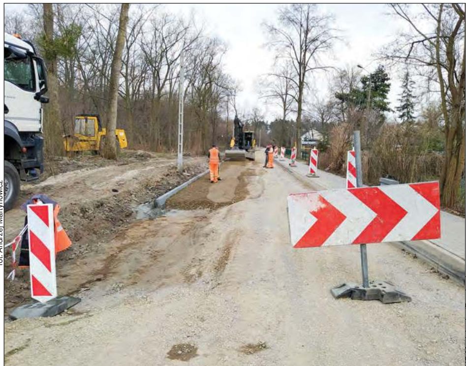
Rozpoczęła się przebudowa drogi gminnej relacji Podzamcze - Malamówka na odcinku 500 metrów w miejscowości Podzamcze
