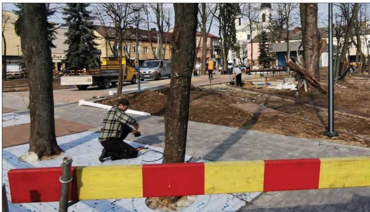
Na terenie inwestycji zamontowane zostały już lampy oświetleniowe, parkowe i lampy oświetlenia na chodniku
