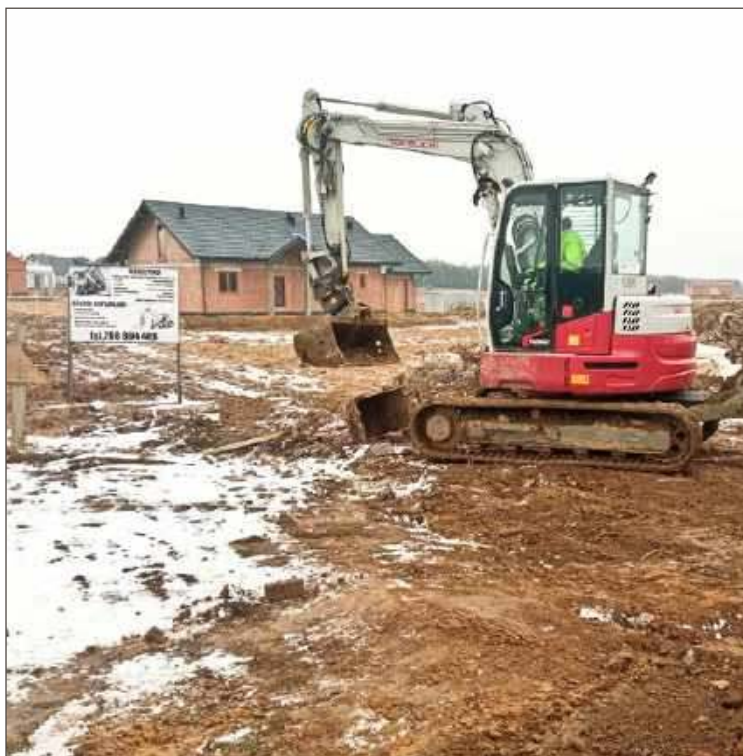
Budowa sieci kanalizacyjnej w Górze Motycznej już się zakończyła.
