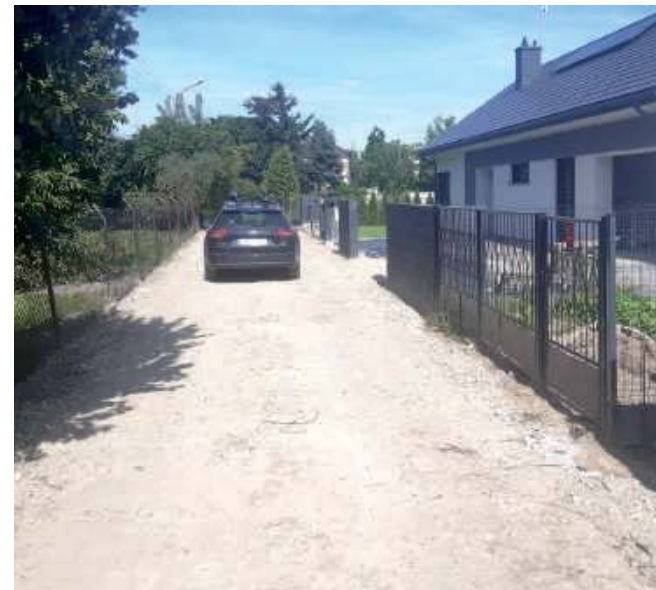
6 września, na ul. Kasztelańskiej sucha, odtworzony został stan drogi sprzed remontu. - Zobaczymy co będzie po deszczu - mówią mieszkańcy.
