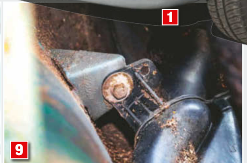
9 WLEW PALIWA. Korozję mocowania zdradzają dopiero pęcherze przy klapce wlewu paliwa.
