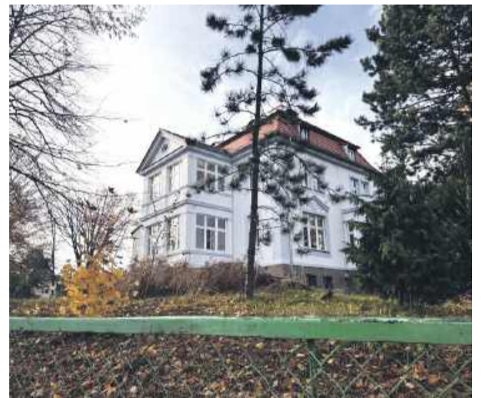
Czesc elewacji czwartej sciany juz odnowiono
