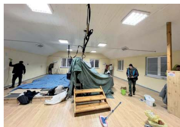
Strażacy z Zamchu sami wyremontowali siłownię
