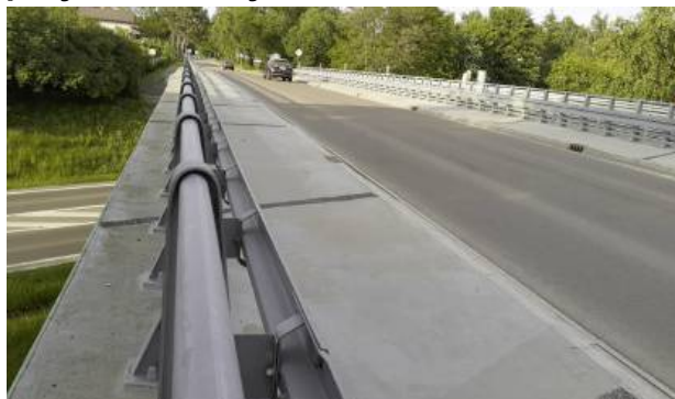
Wiadukt w ciągu ul. Domanickiej już niedługo zostanie wyburzony.
