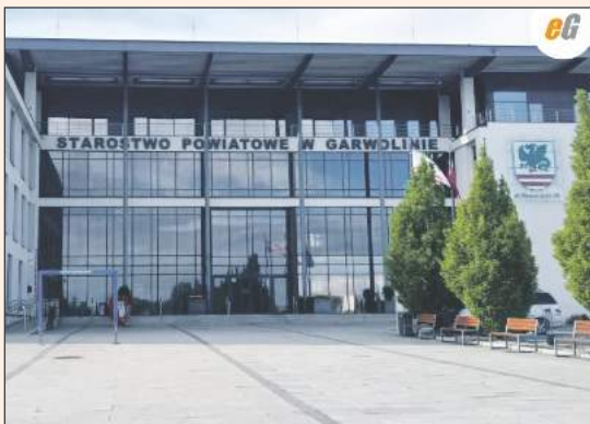
Przeciekający dach, odpadający tynk - "fatalny" stan budynku starostwa
