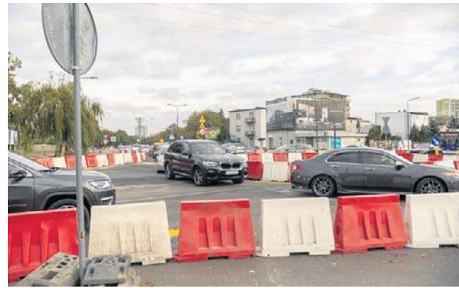
Przebudowa ulicy Sułkowskiego, w tym budowa odcinka trasy rowerowej, potrwa do lutego 2026 roku
