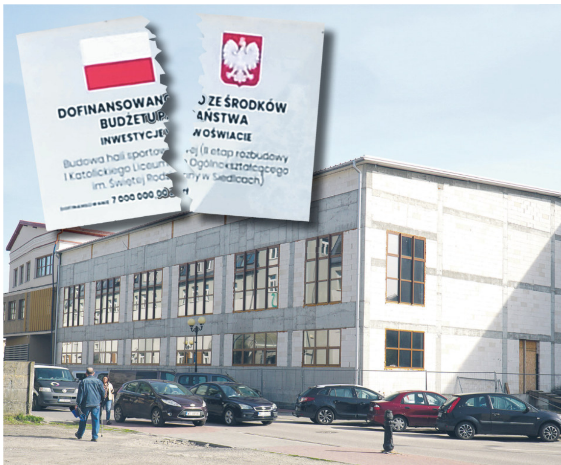
collage: ms Hala sportowa przy I KLO od końca 2023 r. jest w stanie surowym zamkniętym. Pozostaje wykonanie prac we wnętrzu i wyposażenie budynku.
