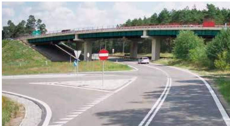
Wiadukty węzła zostaną rozebrane i wybudowane zgodnie z nowymi wytycznymi - informuje GDDKiA
