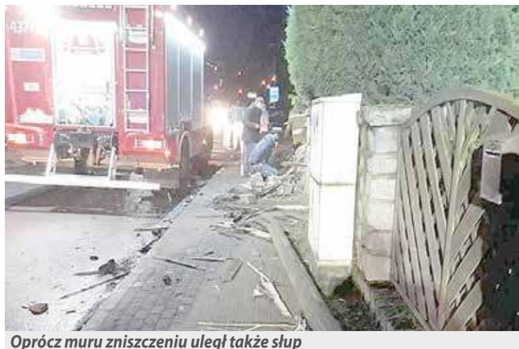
Oprócz muru zniszczeniu uległ także słup
