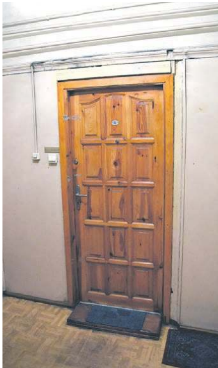
Za tymi drzwiami wydarzyła się tragedia. W wyniku pożaru zginęli dwaj bracia. Najprawdopodobniej zatruli się tlenkiem węgla. Fot. (kt)
