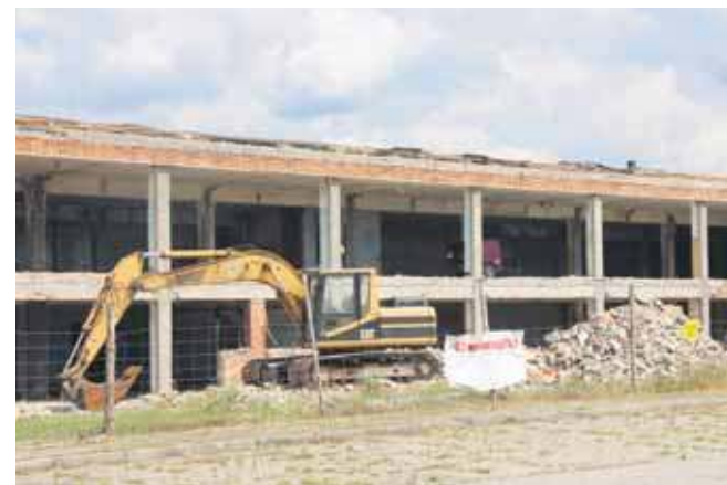
Z przodu kompleksu hal magazynowych przy ul. Zagórskiej widać tony gruzu i koparkę
