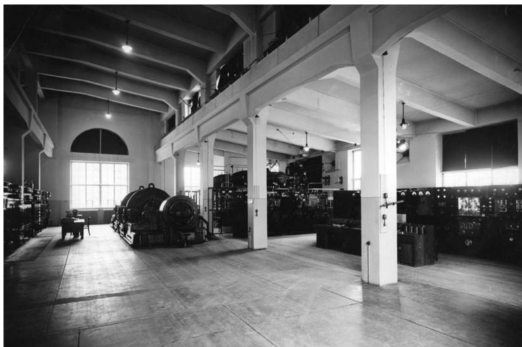
Wnętrze budynku radionadawczego projektu architekta Mariana Kontkiewicza. Widoczne alternatory Alexandersona oraz biurko operatora (NAC)
