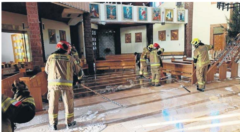
Pożar nie przedostał się do wnętrza kościoła. Strażacy starali się zminimalizować straty powstałe na skutek wody użytej do gaszenia ognia na dachu
