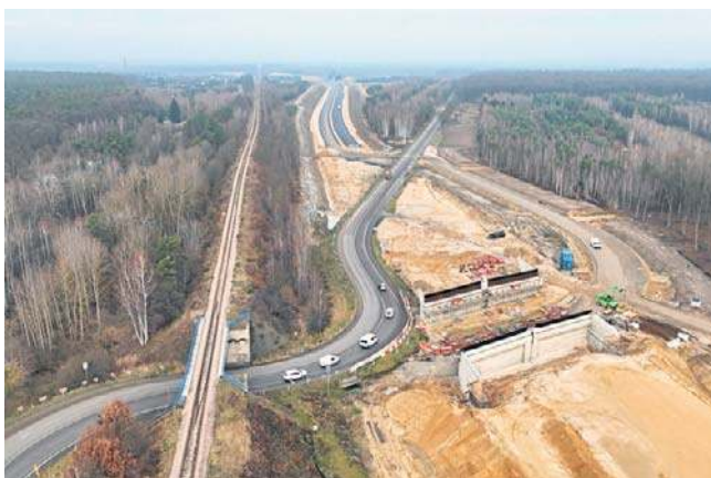
Plac budowy S19 w rejonie wiaduktu kolejowego w Wandzinie
