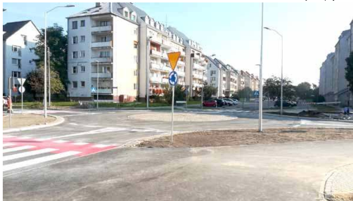
Od dziś kierowcy mogą jeździć po nowym rondzie na os. Pyrzyckim. Rondo zlokalizowane jest u zbiegu ulicy Miłej i Powstańców Warszawy
