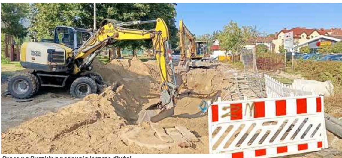
Prace na Puszkina potrwać jeszcze dłużej
