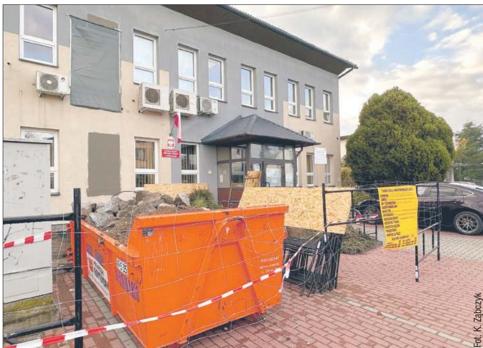
Prace przy urzędzie pracy i liceum w Kolbuszowej już ruszyły. Potrwają około miesiąca.
