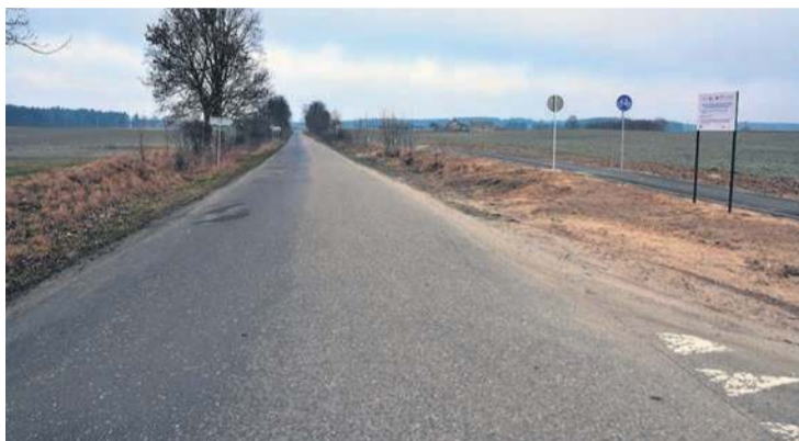
Inwestycja będzie kontynuowana od przepustu w centrum Wełpina w kierunku Cekcyna na 1690 metrowym odcinku.
