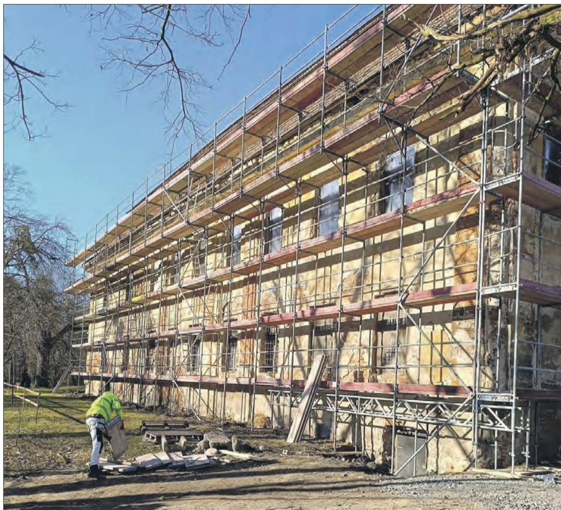
Widomy znak początku remontu Pałacu Rozkochów. Rusztowania otoczyły skrzydło południowo-zachodnie, które jest odnawiane w ramach obecnie realizowanej inwestycji.
