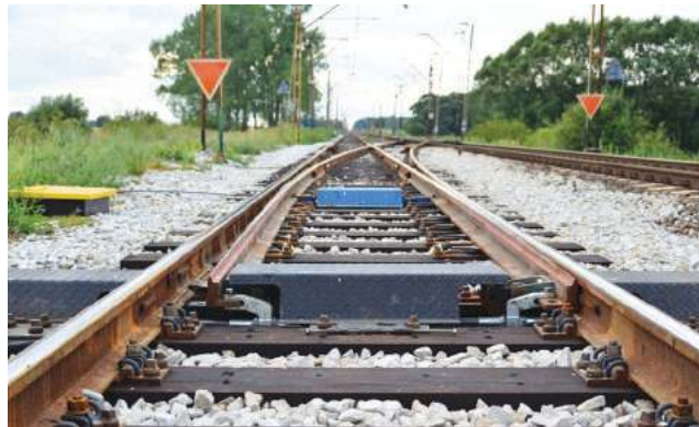
Budowa nowej linii ma się zakończyć do 2029 r.
