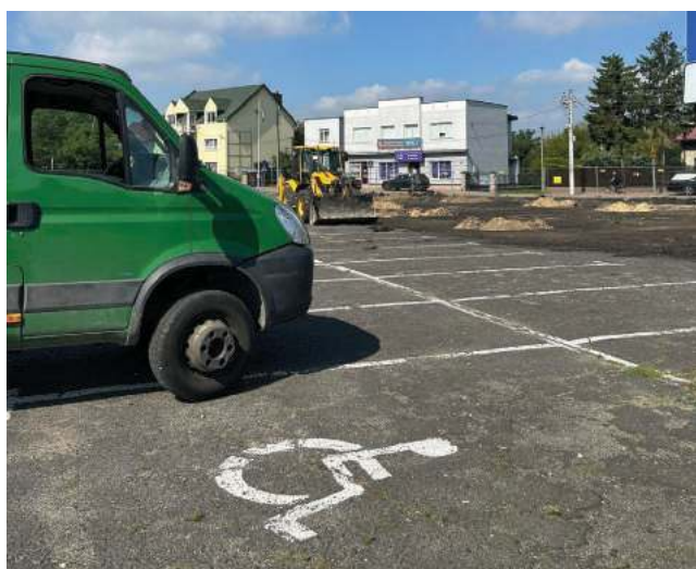
Z placu znika stara asfaltowa nawierzchnia
