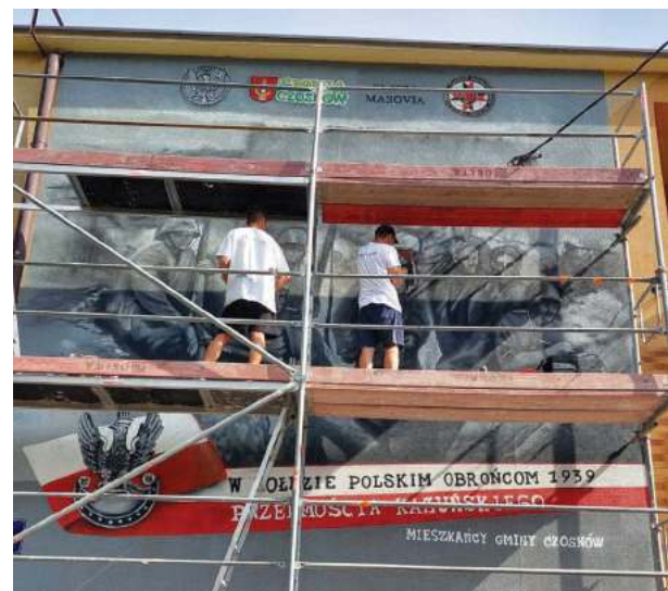
Trwają prace nad murem na budynku ZS-P w Kazuniu Nowym
