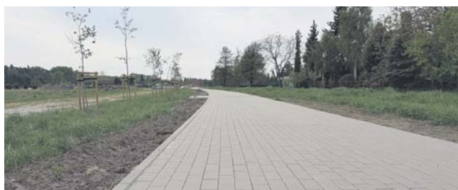
Rowerowa obwodnica wzdłuż Olszynki
