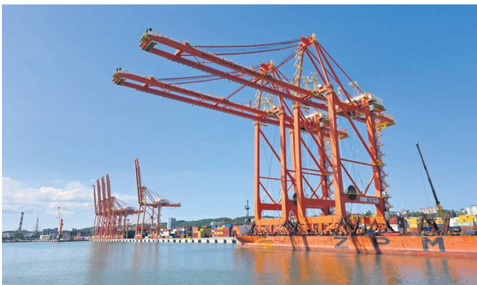
ZMPG S.A./ Nabrzeże Helskie po przebudowie
