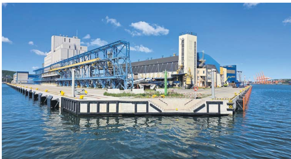
ZMPG S.A./ Nabrzeże Indyjskie po przebudowie
