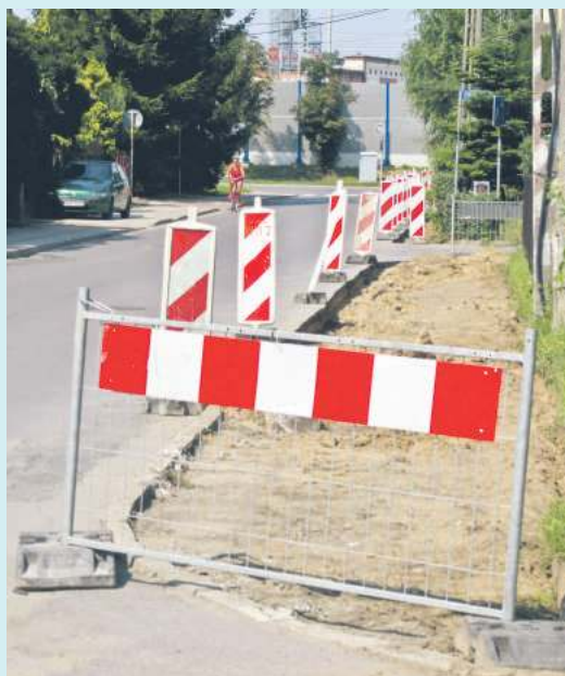
Przy ul. Parkowej remontowany jest chodnik.
