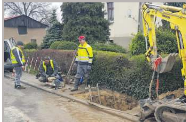
W miniony czwartek, 21 kwietnia, przy ul. Ziębickiej w pobliżu skrzyżowania z ul. Strze- lińską pracownicy Zakładu Usług Komunalnych w Przewornie usuwali awarię sieci wodociągowej
