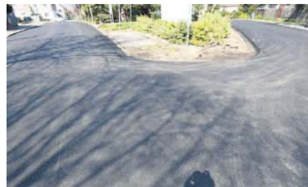
Nowy asfalt robi bardzo dobre wrażenie
