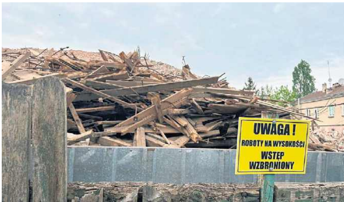
Główne prace rozbiórkowe młyna zostały już zakończone.
