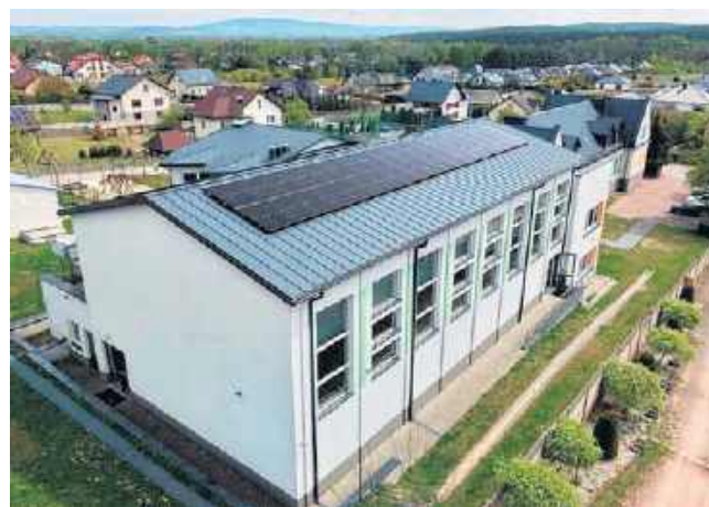
Instalacje zamontowano na szkołach w Mójczy i Niestachowie (na zdjęciu)
