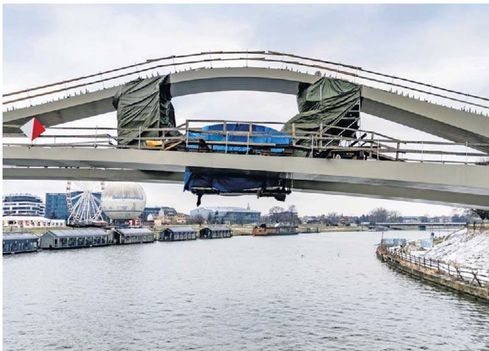
Budowa kładki Kazimierz - Ludwinów jest coraz bliżej ukończenia
