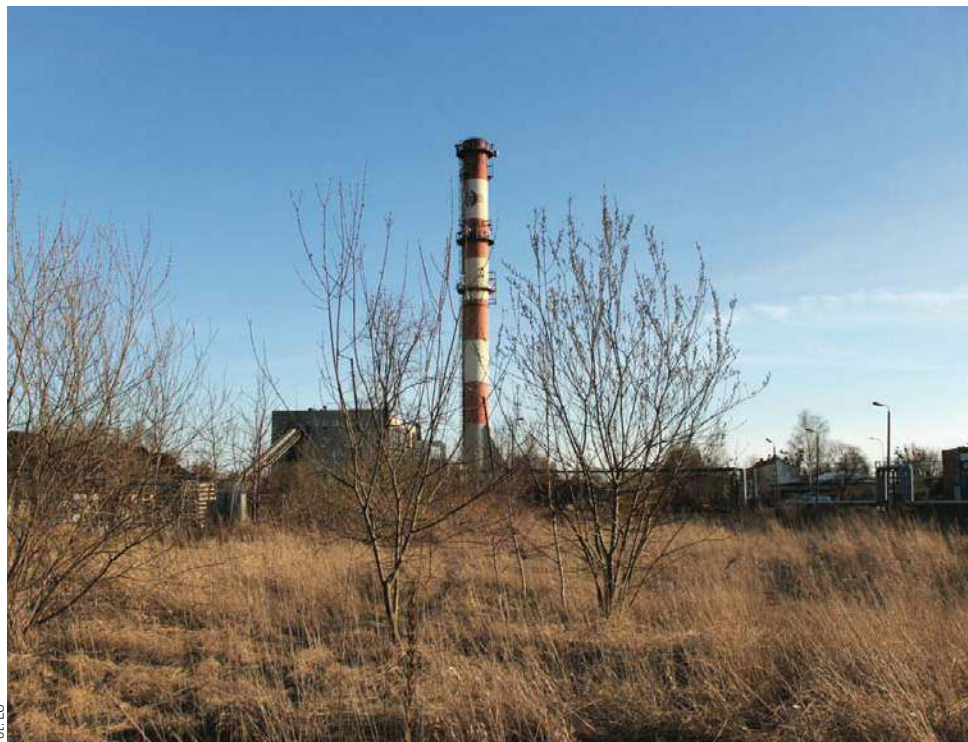
Tu ma powstać nowa elektrociepłownia
