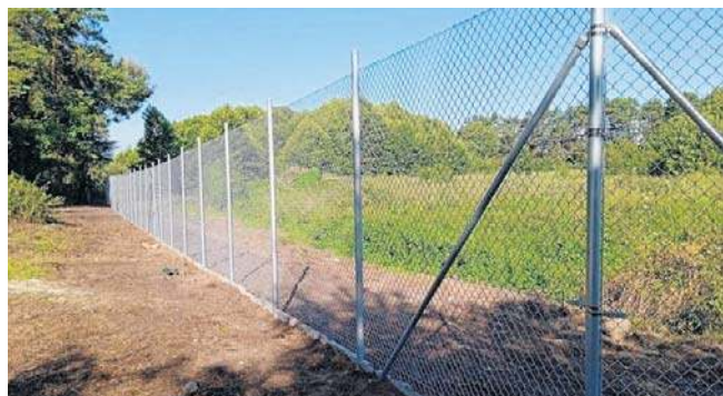
Zakończyła się wymiana ogrodzenia Cmentarza Komunalnego w Wągrowcu.
