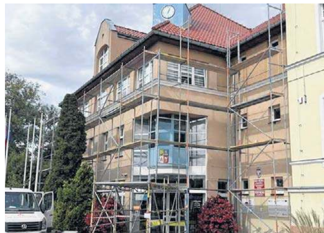
Remont dachu i podbitki w Urzędzie Miejskim. Całość kosztować będzie prawie 90 tys. zł
