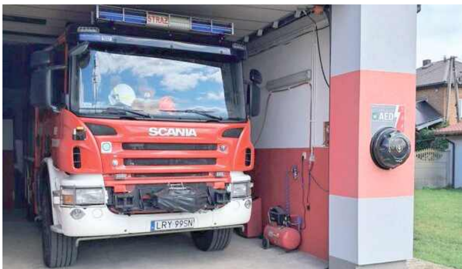
Na ścianie garażu jednostki zamontowano defibrylator AED, który może pomóc w przypadku nagłego zatrzymania krążenia. Zakup urządzenia był inicjatywą strażaków, a jego realizację wsparli mieszkańcy
