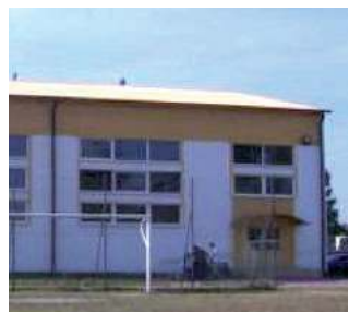
Halę sportową oddano do użytku w 2006 roku po dwóch latach budowy
