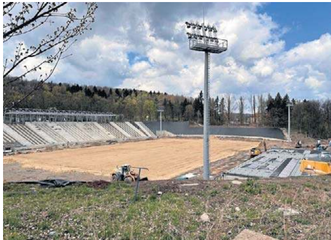
Tak wygląda stadion na Nowym Mieście opuszczony przez wykonawcę, firmę Moris Polska
