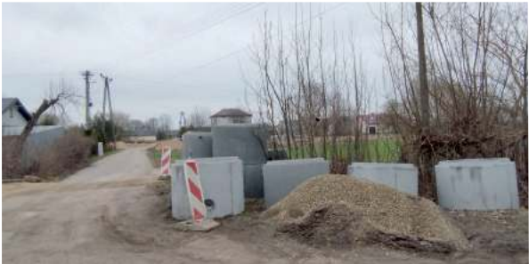
Budowa sieci kanalizacyjnej wraz z przyłączami w miejscowościach Jabłoń i Wantopol
