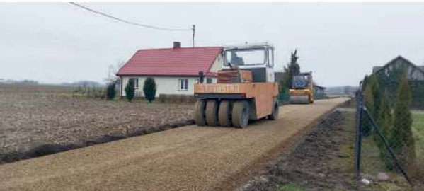
Budowa drogi gminnej nr 104069L w miejscowości Kolano
