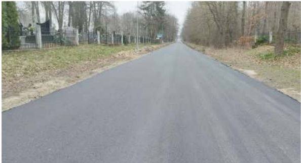
Przebudowa drogi powiatowej nr 1099L w miejscowości Jabłoń
