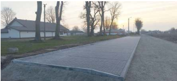
Budowa drogi gminnej nr 103765L w miejscowości Gęs
