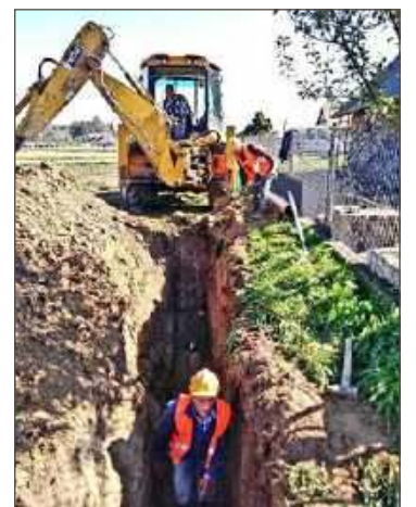
Prace trzeba będzie zakończyć w 2024 roku. fot. ZGDW
