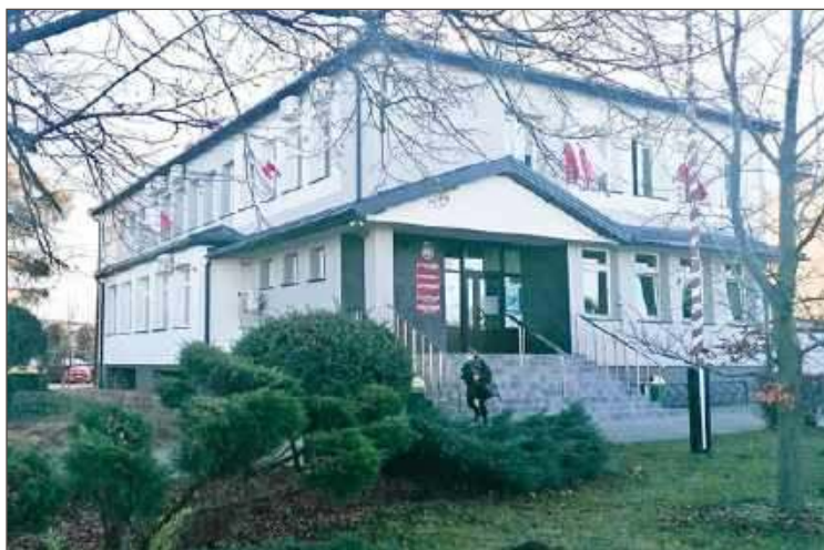
Budynek Urzędu Gminy już po remoncie.
