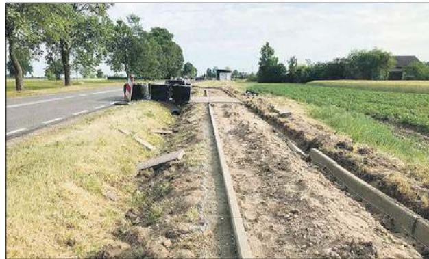
Wzrośnie bezpieczeństwo pieszych, gdyż w Dubowie remontowany jest chodnik
