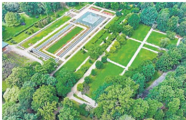
Prace rozpoczną się we wrześniu
