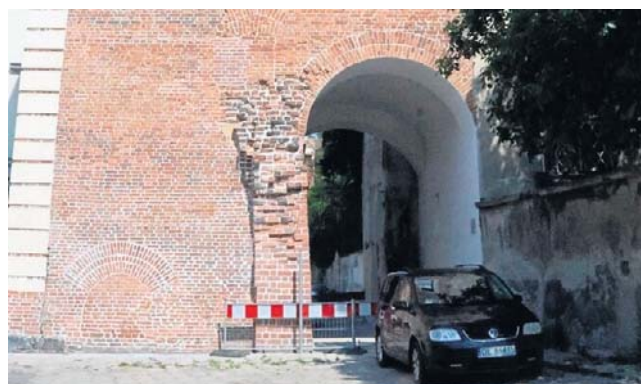
Przejazd bramny jest już wyremontowany, ale wciąż zamknięty
