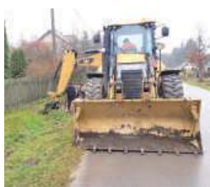
Jednym z elementów zabezpieczeń ma być udrożnienie rowów problem. Wójt zapewnia, że prace zakończą się wiosną.
