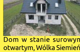
Dom w stanie surowym otwartym, Wólka Siemieńska, 885 851 160
