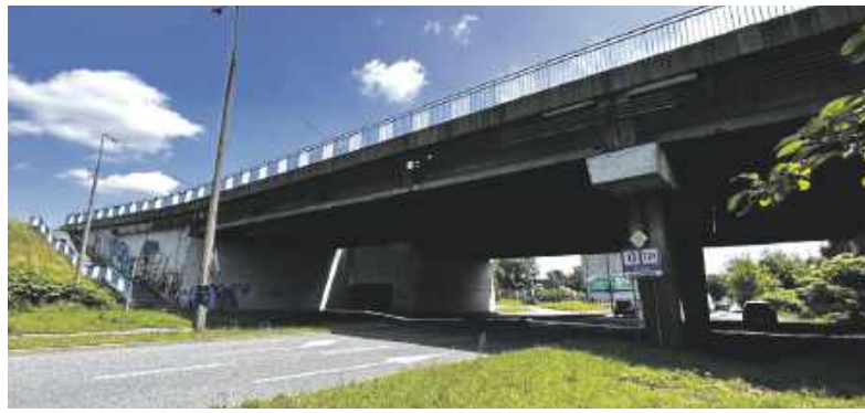
Wiadukt nad Siemianowicką ma kilkadziesiąt lat
