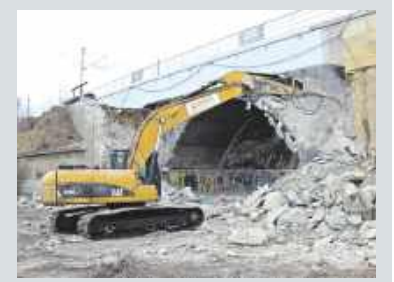
Wiadukt pomiędzy Radzionkowem, a Rojcą wyburzono i wzniesiono na nowo
