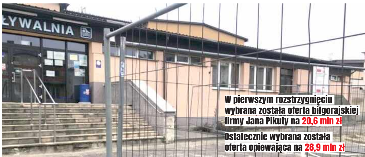
Tak z zewnątrz obecnie wygląda biłgorajska kryta pływalnia
