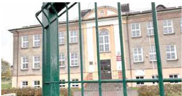
Szkołę we Frampolu czeka wymiana części okien i drzwi. Ściany budynku zostaną też ocieplone
