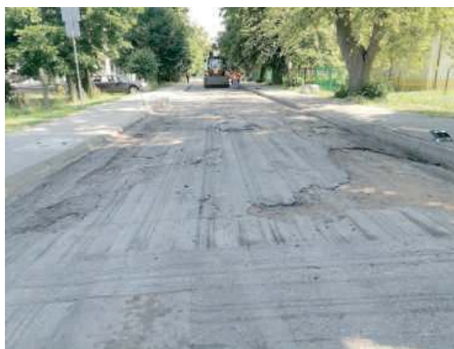
Zanim wyłożona została nowa jezdnia, drogowcy frezowali nawierzchnię
