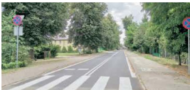
Tak wygląda ul. Lipowa po zakończeniu prac
