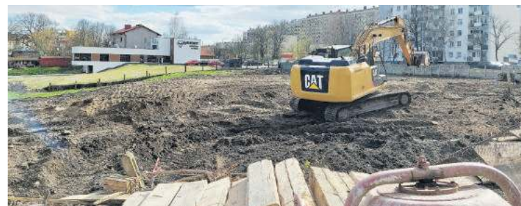
Obecnie na placu budowy pracuje ciężki sprzęt
