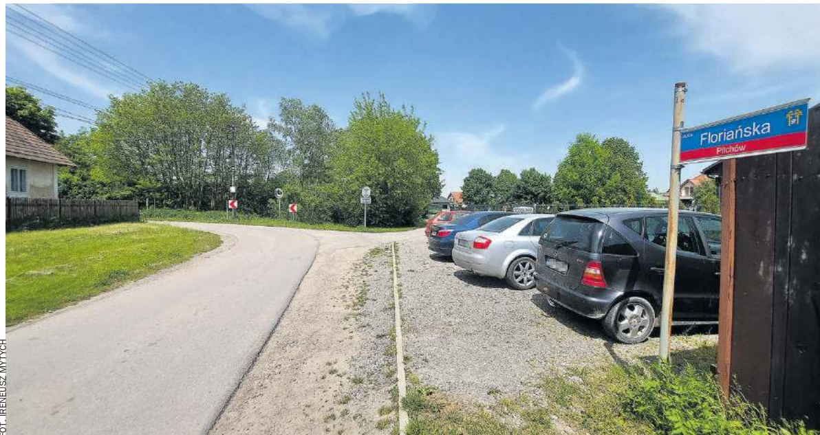
Przebudowie poddany zostanie odcinek o długości blisko 1 km
