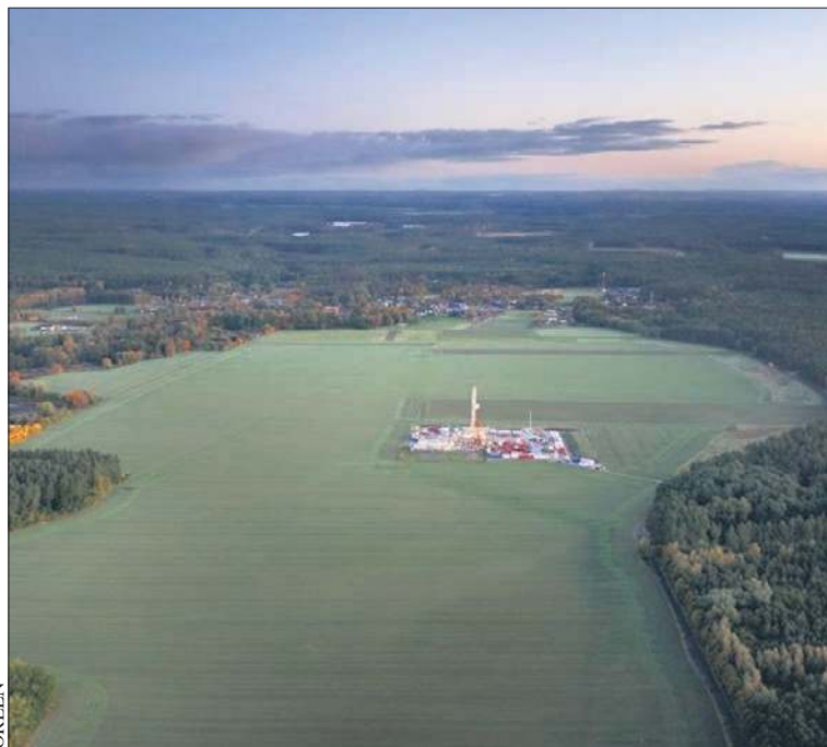
ORLEN rozpoczął eksploatację złoża Różańsko
