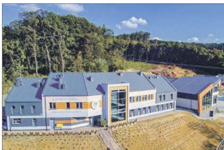
Poszło o instalację fotowoltaiczną dla uzdrowiska. Fot. UG w Dębicy.
