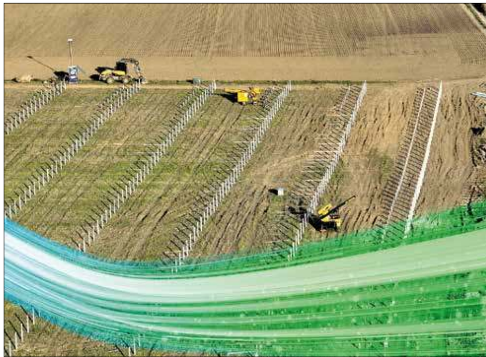
Budowa farmy fotowoltaicznej Dygowo I
