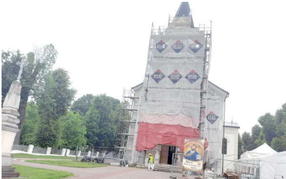
Remont kościoła w Łukowej potrwa jeszcze półtora roku
